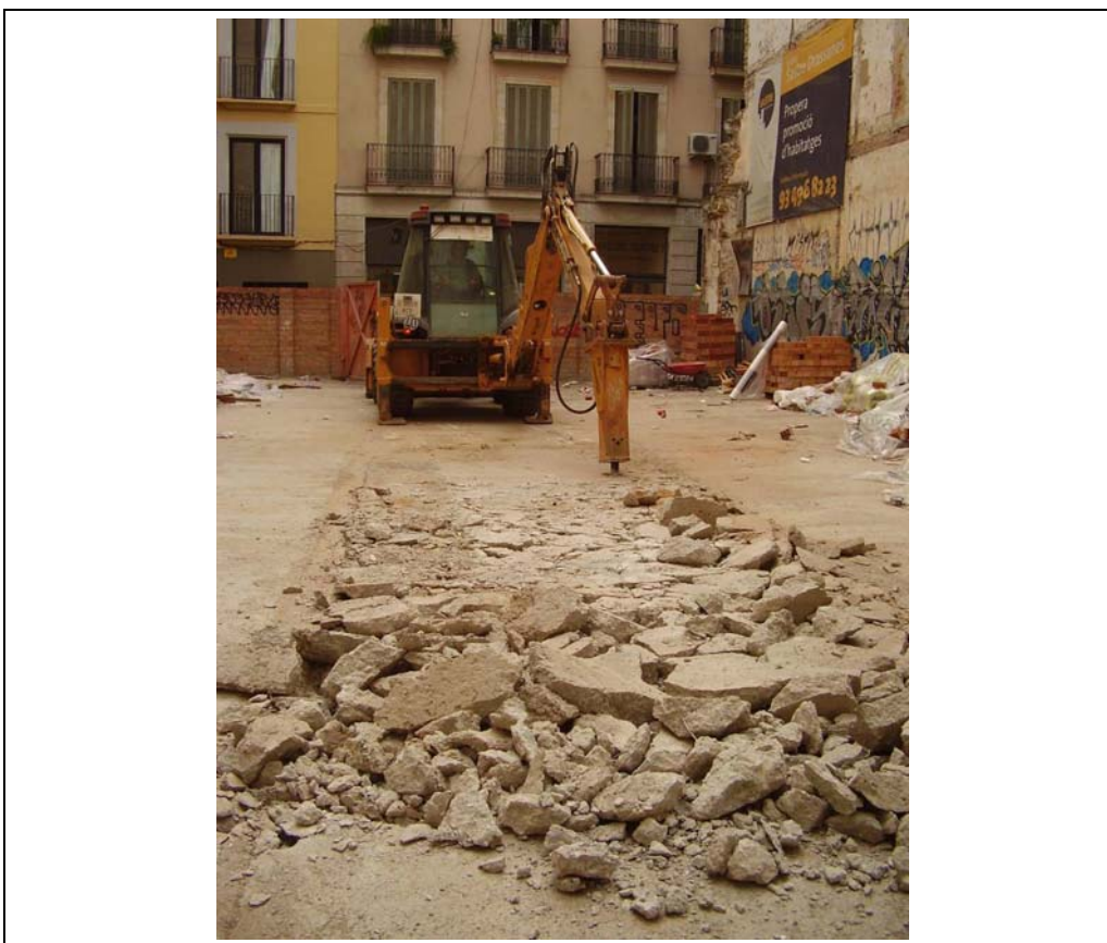
Foto 22: Rasa 2. Retirada del paviment de formigó
