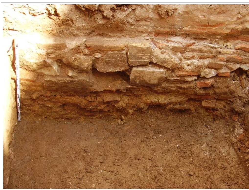
Foto 46: Rasa 2. Alçat del mur UE 2012
