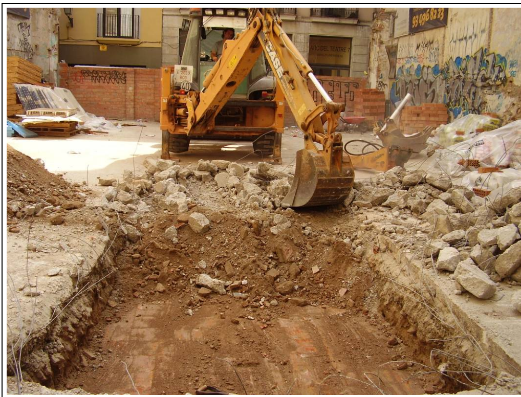
Foto 23: Rasa 2. Neteja del paviment UE 2001
